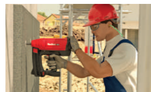
A cabeça (adicional) EWI para a FGC 100 permite a fixação de sistemas de isolamento
