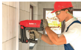
Para uma fixação rápida e segura das calhas em gesso cartonado
