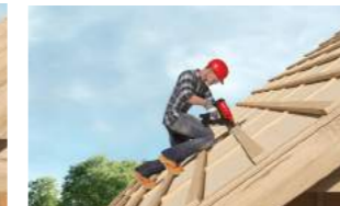
A capacidade de fixações com sequências permite realizar o trabalho de forma rápida
