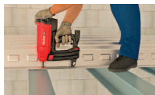
Para fixação temporária da chapa colaborante da laje mista às vigas de aço
