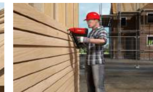
Tampa protetora para proteger a superfície da madeira em áreas visíveis, por exemplo, revestimento exterior
